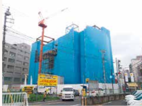
東京消防庁練馬消防署庁舎（24）新築工事 SRC造 平成27年2月竣工 （撮影日 上：平成27年2月 下：平成26年6月）
