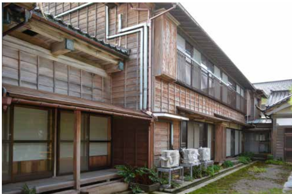
本館行在所 外観 南東より
