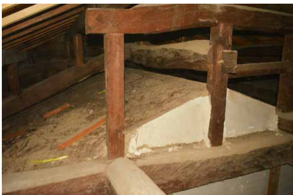
長屋門 小屋裏 南西より 東側端部が土蔵となる
