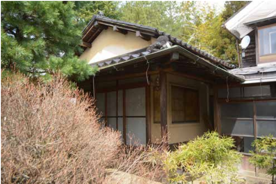
小出家住宅 洋間 外観 南東より
