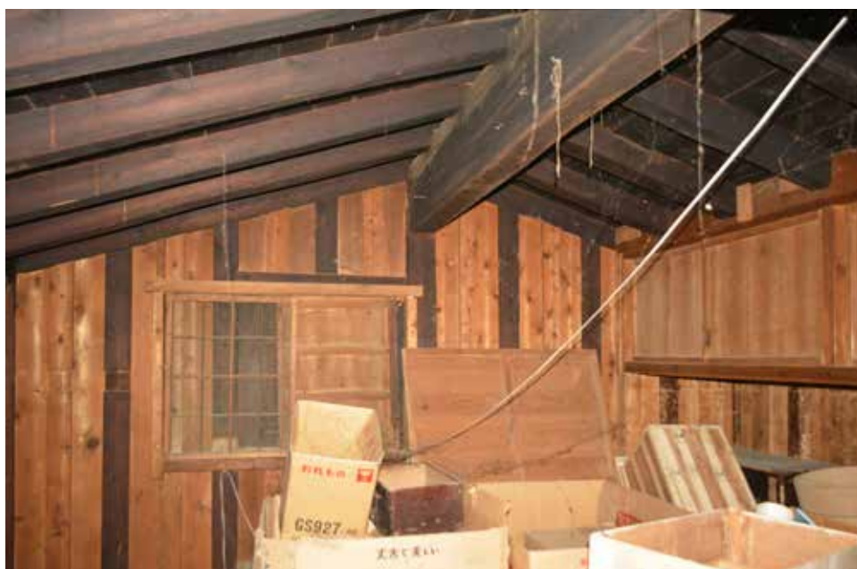
土蔵 2階 北西より
