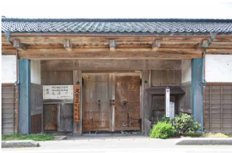
長屋門 外観 南東より
