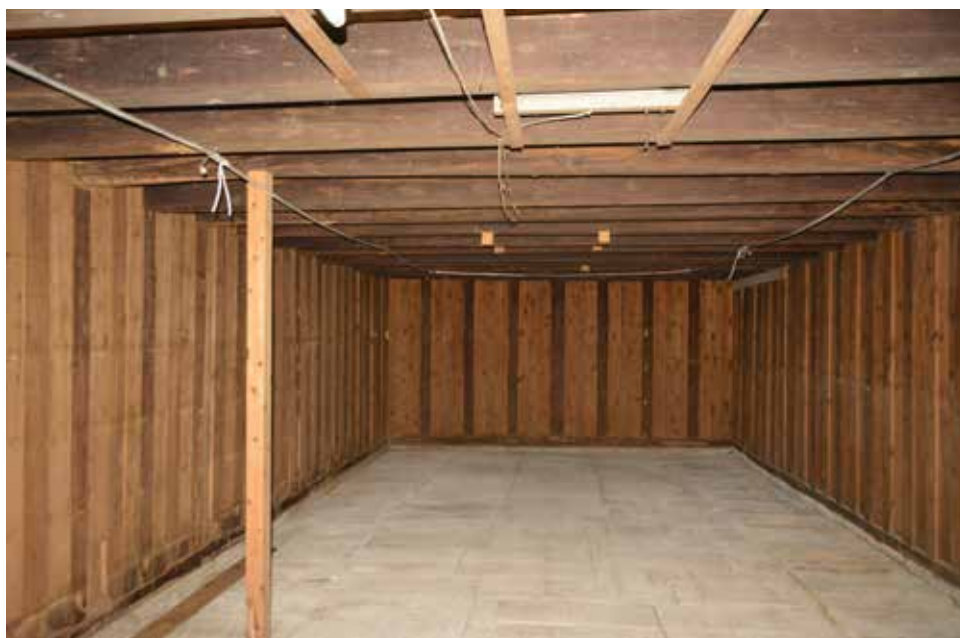
土蔵 1階 北西より
