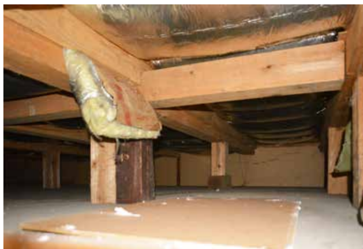
小松酒店サカグラ 天井スラブ上 東より
