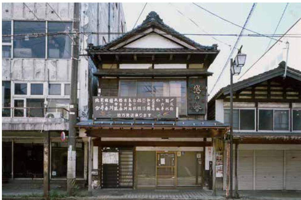
小松酒店 店舗兼主屋 外観 北より
