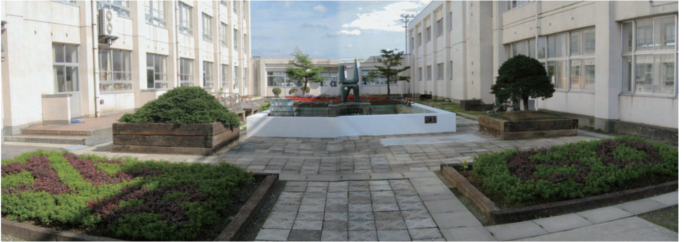
写真-5 完成状況（西側より全景）
