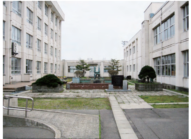
写真-1 整備前の状況
