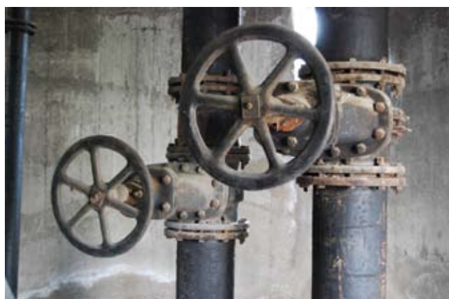
写真2 1階送水管弁
