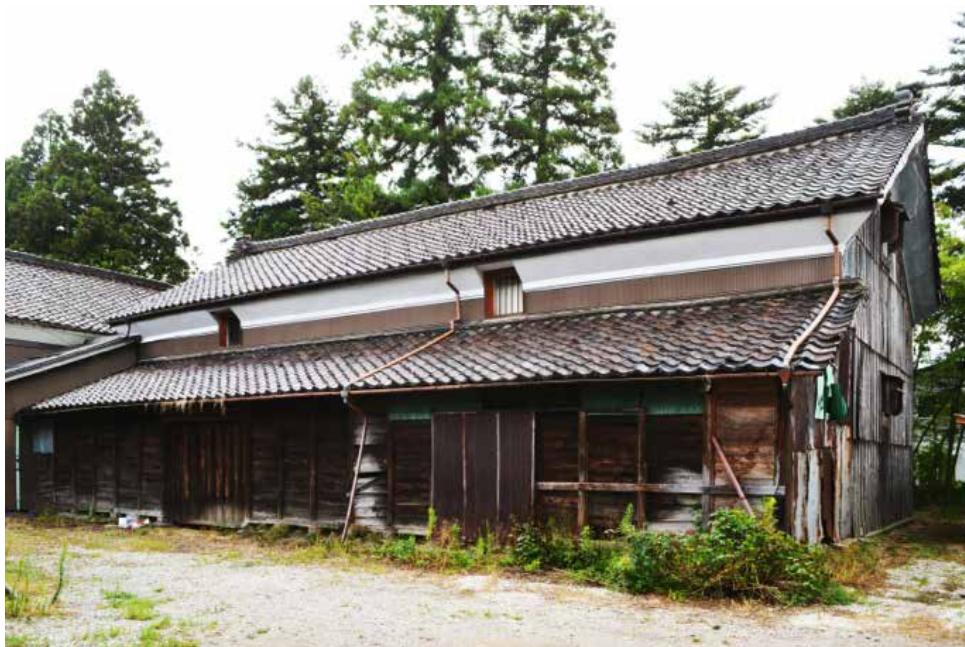
写真7 道具蔵 北東より
