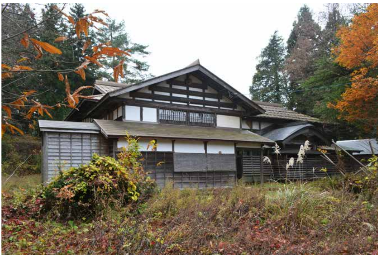
早川家住宅主屋 北東より
