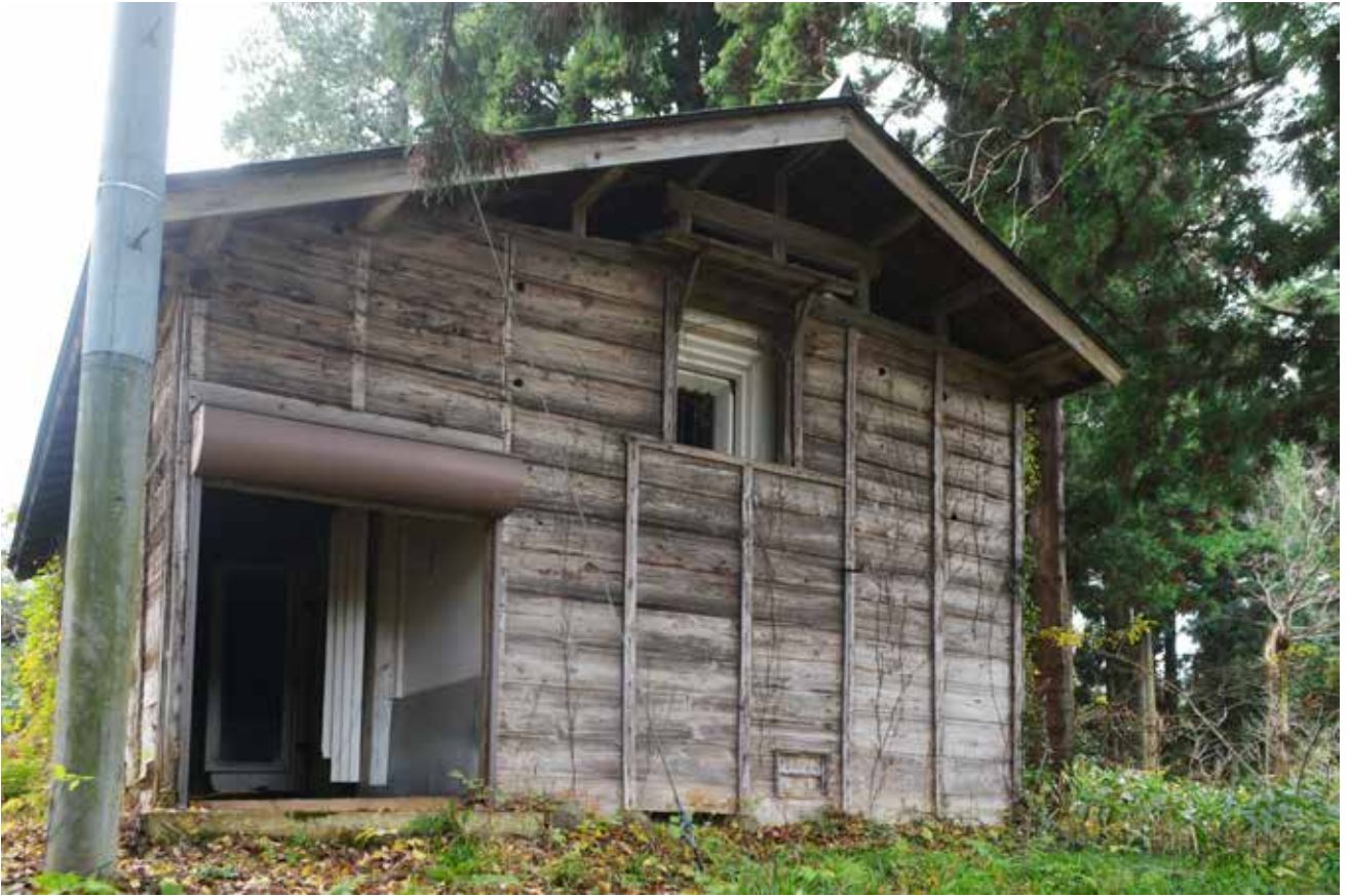
早川家住宅土蔵 北東より
