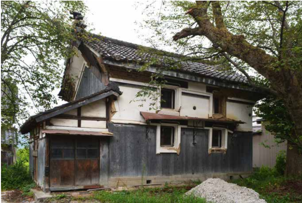
写真5 一号蔵 南西より
