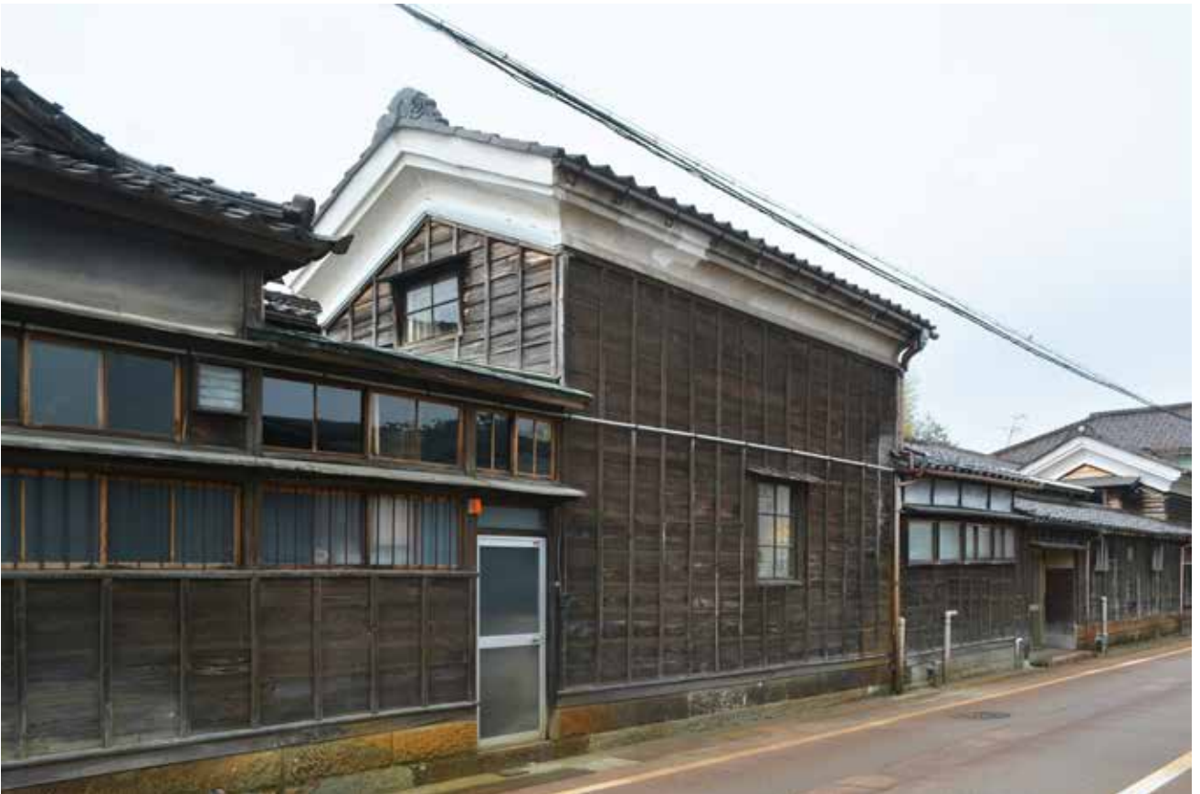
小出家住宅コメグラ 南東より
