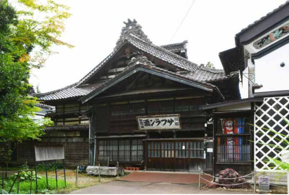
写真1 主屋 北東より
