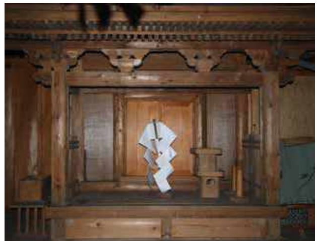
写真 5 飯綱社 本殿 (北より)
