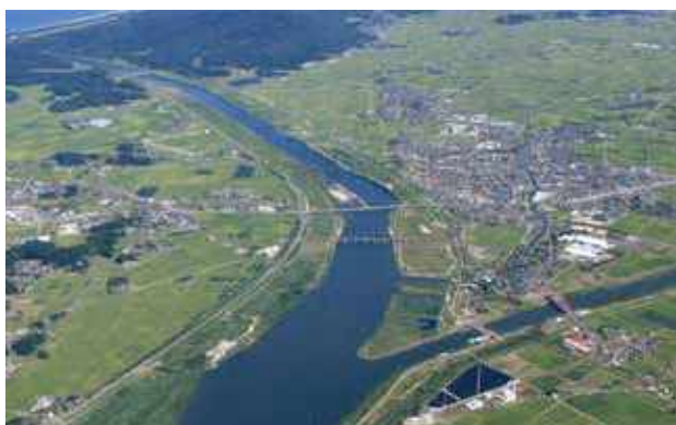
大河津分水の全景 (写真提供：信濃川河川事務所)
