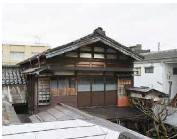
写真 2-2 小出家住宅主屋 外観 北東より
