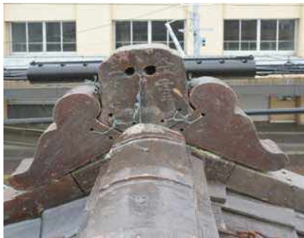
写真 2-1 小出家住宅主屋 北東より
