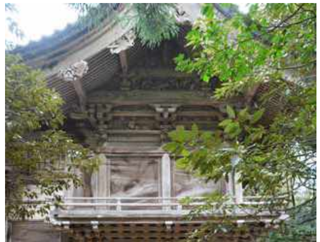
写真 2 御島石部神社 本殿 東より
