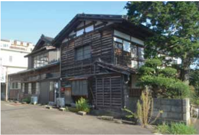
写真 3 主屋外観 南東より
