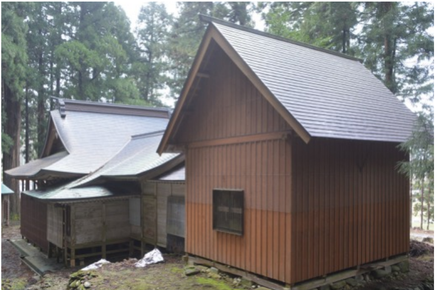
八木神社 本殿覆堂 外観 北東より
