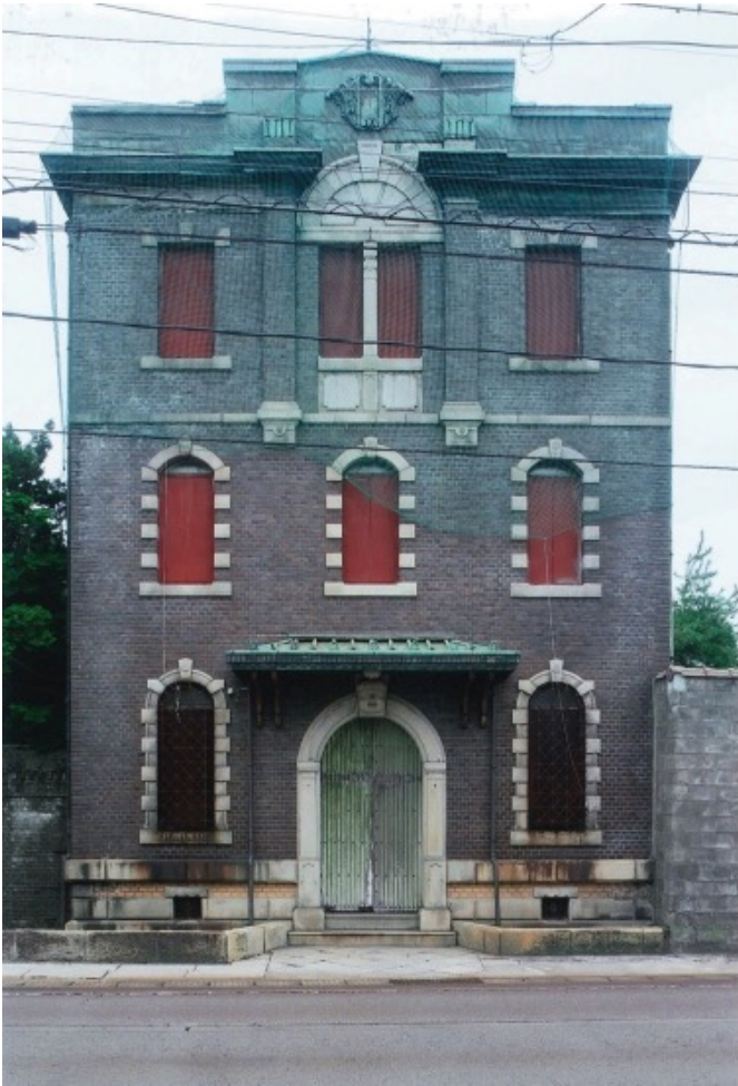
旧今井銀行店舗 外観 東より (田村 収撮影)
