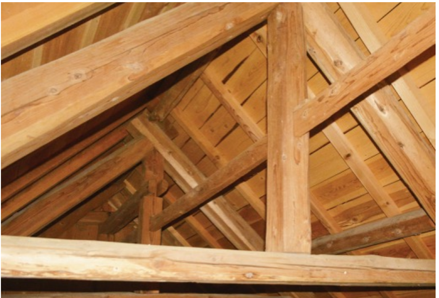
八木神社 本殿 覆堂 小屋組 北西より
