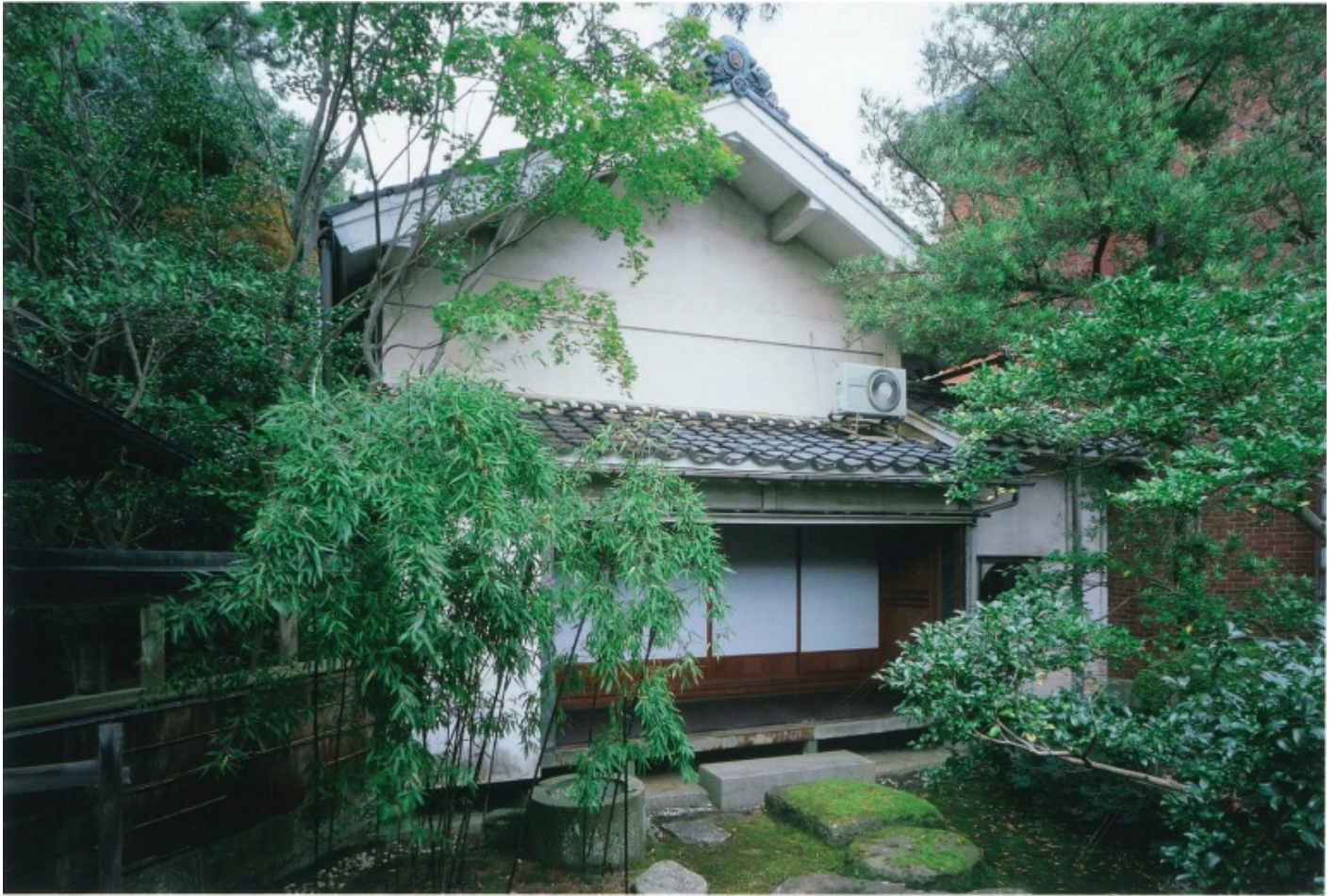
新座敷 外観 南東より（田村 収撮影）
