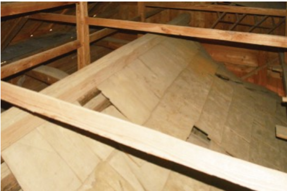
八木神社 本殿 屋根 南西より
