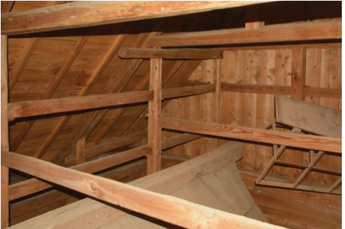
八木神社 本殿 覆堂 小屋組 南西より
