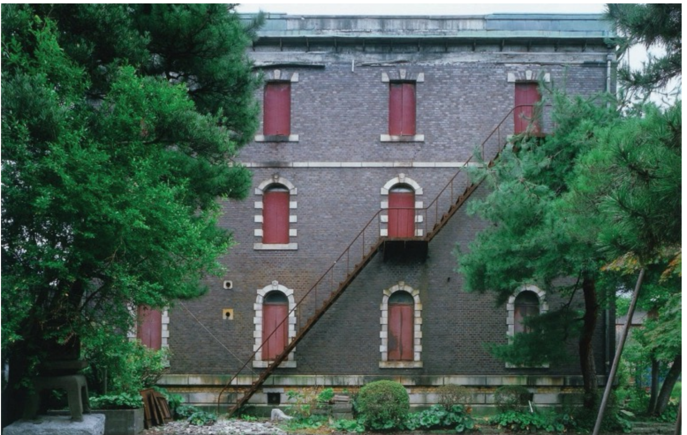
旧今井銀行店舗 外観 北より (田村 収撮影)
