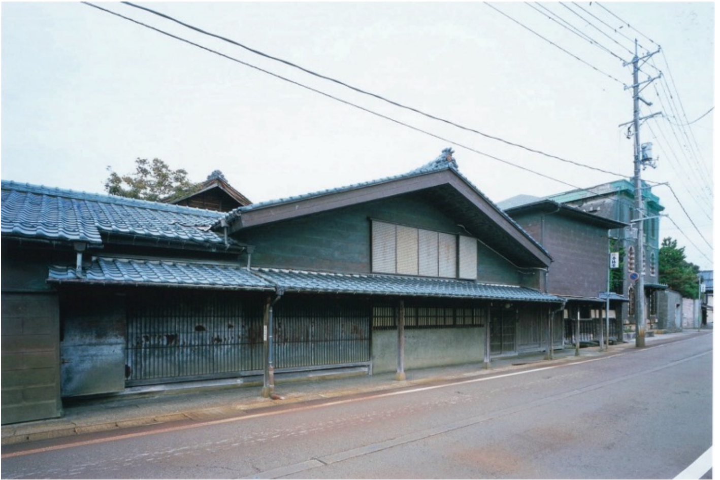
主屋 外観 南東より（田村 収撮影）
