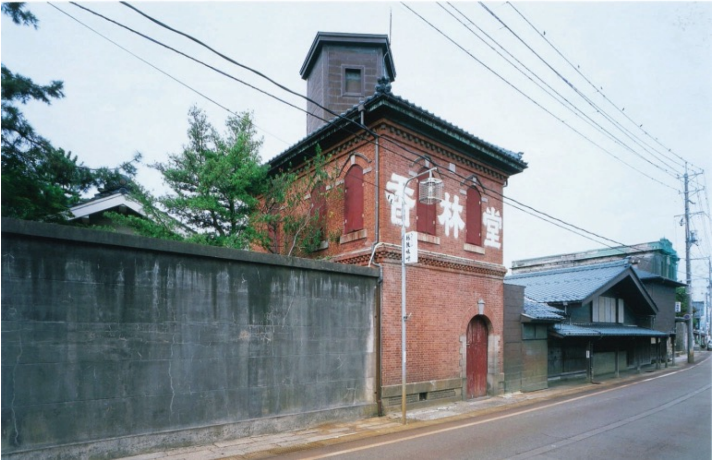
西洋館 外観 南東より (田村 収撮影)
