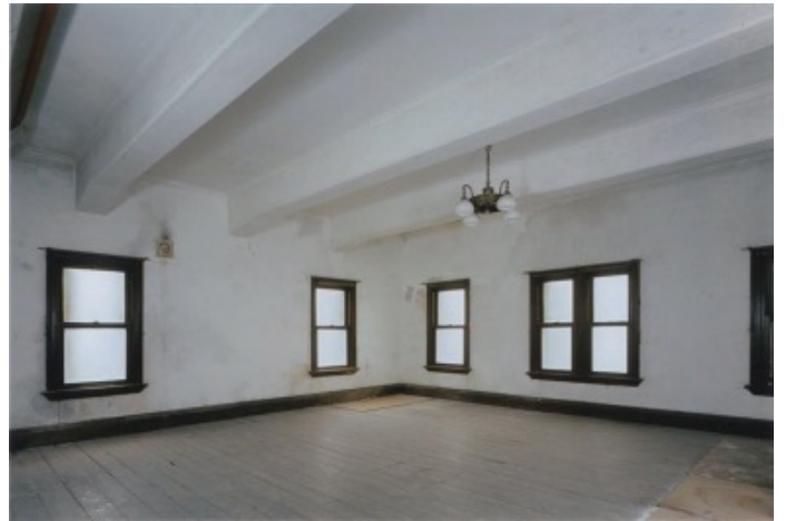
旧今井銀行店舗 3階大講堂 北西より (田村 収撮影)
