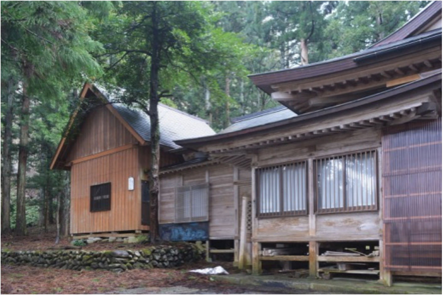
八木神社 本殿覆堂 外観 南西より
