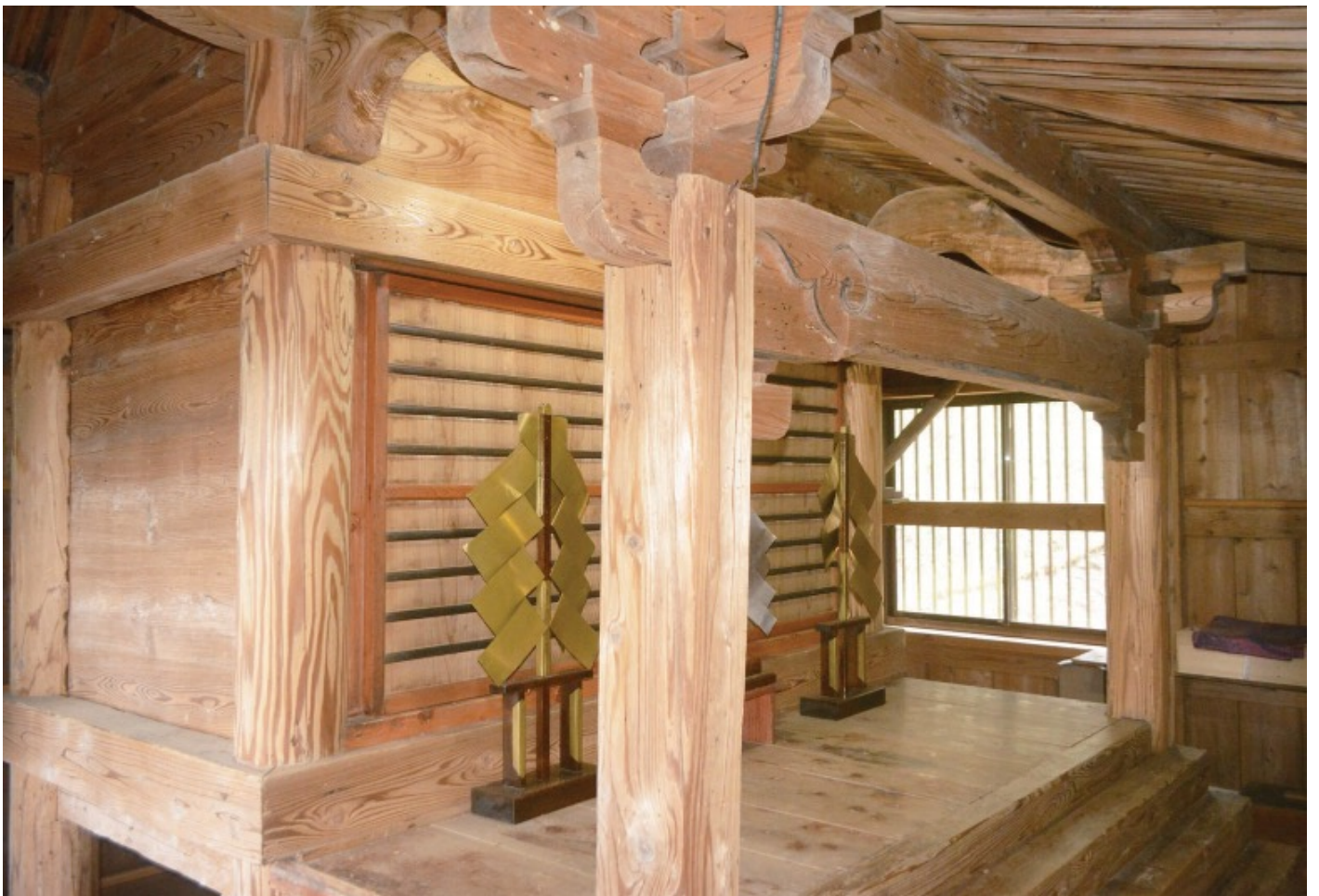
八木神社 本殿 外観 南西より
