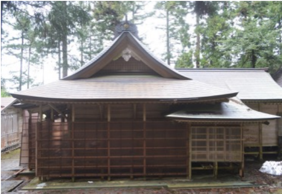
八木神社 拜殿 外観 東より
