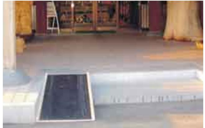
写真1 簡易スロープの設置
