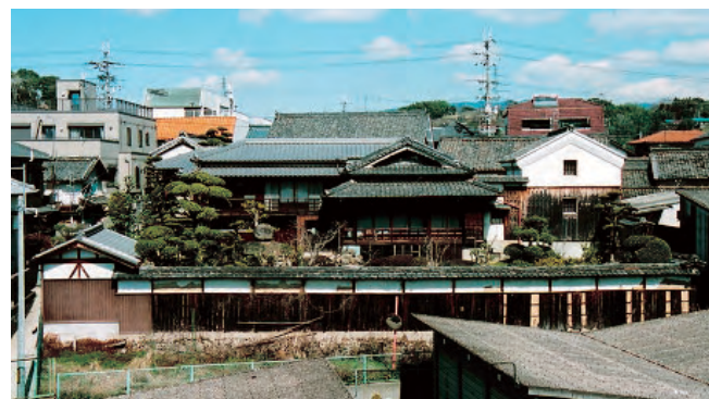
佐藤家住宅主屋座敷全景 南より
