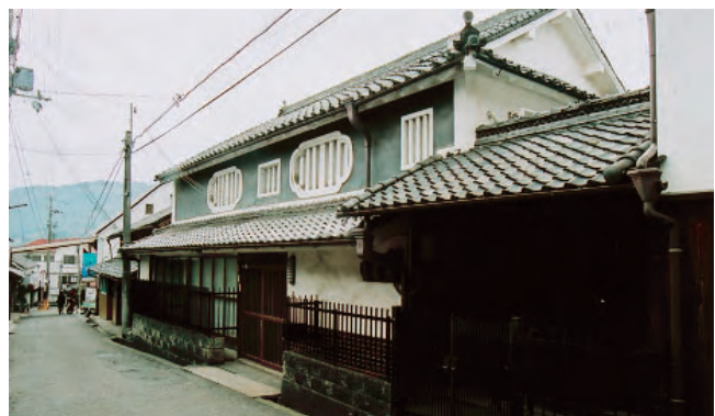
佐藤家住宅主屋全景 北西より
