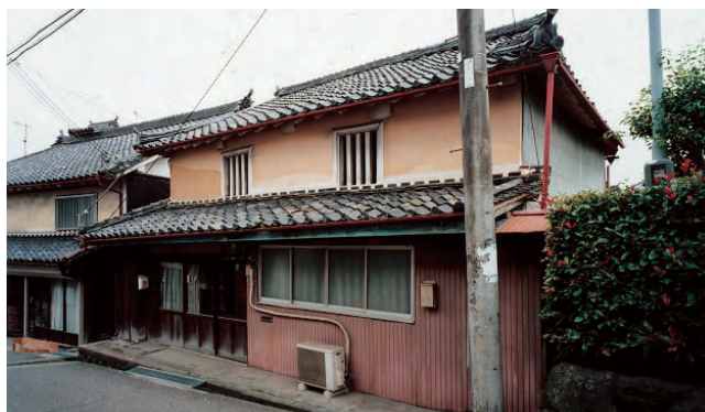
堀江家住宅主屋全景 北西より
