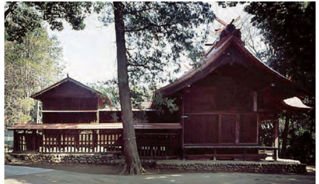
八幡神社本殿覆殿、拝殿全景 西より
