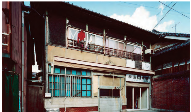
加藤家住宅倉庫全景 南西より
