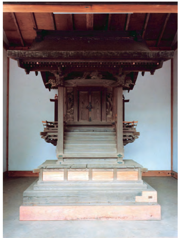
稲荷神社本殿全景 南より
