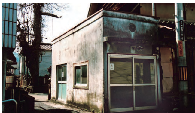
旧消防団倉庫 北より
