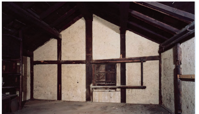
土生家住宅土蔵2階 南より
