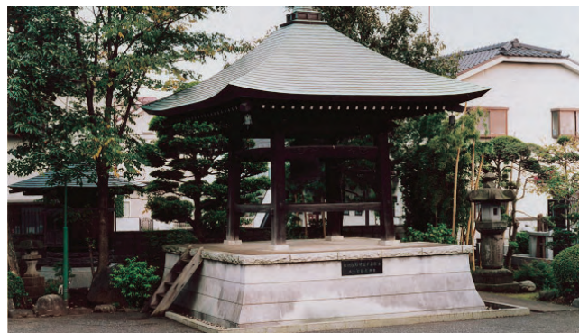
鳳林院鐘楼全景 北西より
