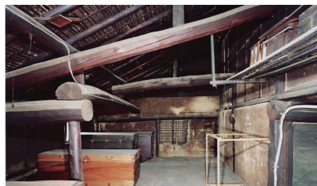
土生家住宅主屋小屋裏 東より
