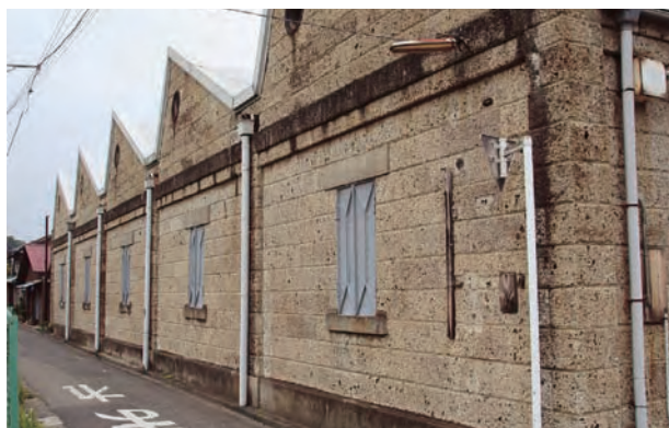
担当したノコギリ屋根工場
