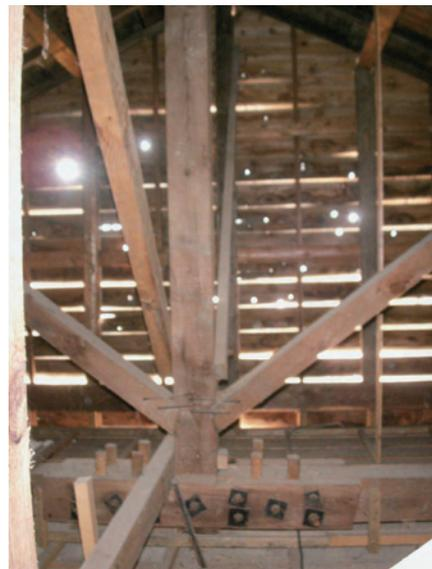
写真19 公会堂集会所上部の小屋組み(現在) トラスの材料は新材であることがわかる。
