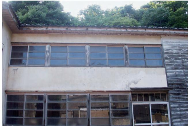
写真17 軒廻りの仕上げ 東面と南面には天板が張られ、軒先には鼻隠し板が取り付けられている。
