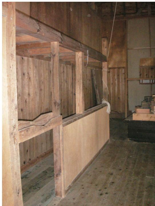
写真12 西側花道北端の様子 花道の北側は壁板が下半分にだけになっている。芝居をするときの楽団が入るための場所。
