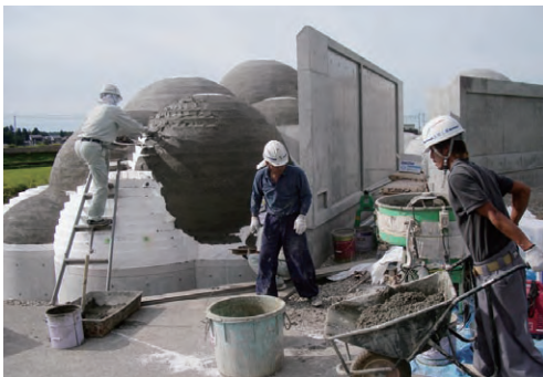
1/10模型 (現場製作手順と同じ工程で作成) 上:EPS板の積層模型 中:EPS板にモルタルを吹き付ける 下:モルタルの上から苔を植栽
