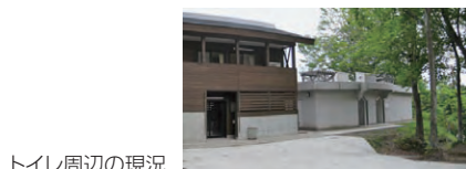
トイレ周辺の現況
