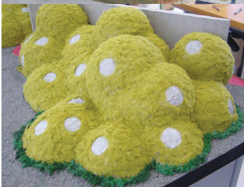
1/10模型 (現場製作手順と同じ工程で作成) 上:EPS板の積層模型 中:EPS板にモルタルを吹き付ける 下:モルタルの上から苔を植栽
