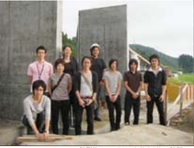
脱型後のコンクリート仕上げの確認
