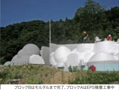
ブロックBはモルタルまで完了、ブロックAはEPS積層工事中
