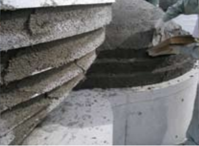
1層目のモルタルでEPSの段々をつぶす
