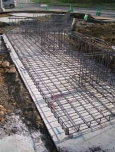
基礎底版の配筋工事
