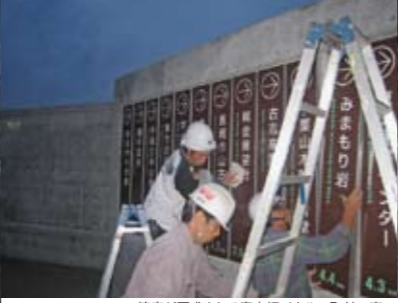
精度が要求される案内板パネルの取付工事
