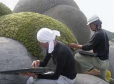
コケ張り作業は、2層目のモルタルと合い判で
