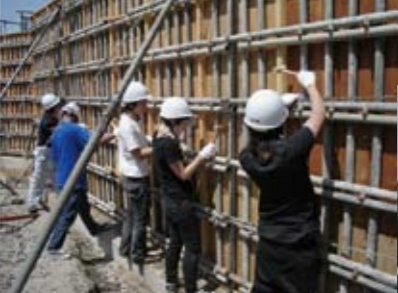
コンクリート打設における木陸たたき
