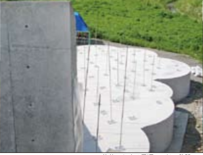
後施工による貫通ロッドの敷設
