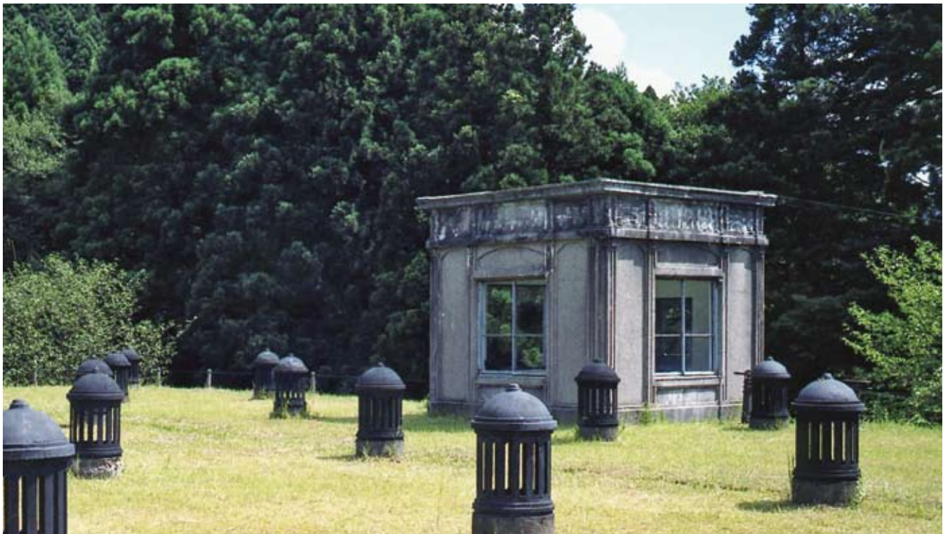
写真5 配水池機械室
