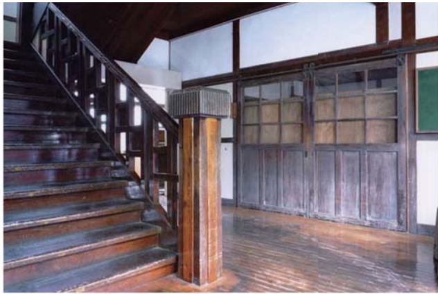
(4) 南校舎 1階階段室 北東より
