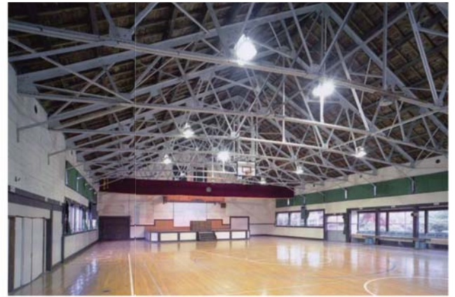
(7) 体育館 内部 南東より
