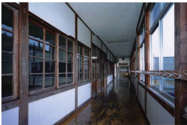
(6) 南校舎 2階廊下 東より
