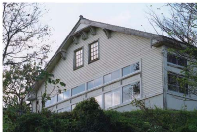
(3) 体育館 外観 南東より
