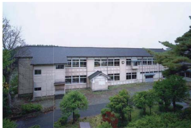
(2) 南校舎 外観 北より
