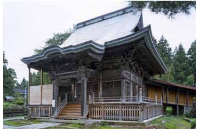
真福寺 観音堂 北東より
