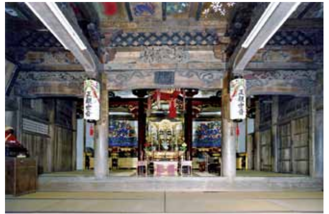
真福寺 観音堂 東より
