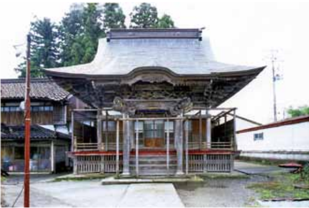
観音寺 観音堂 北より
