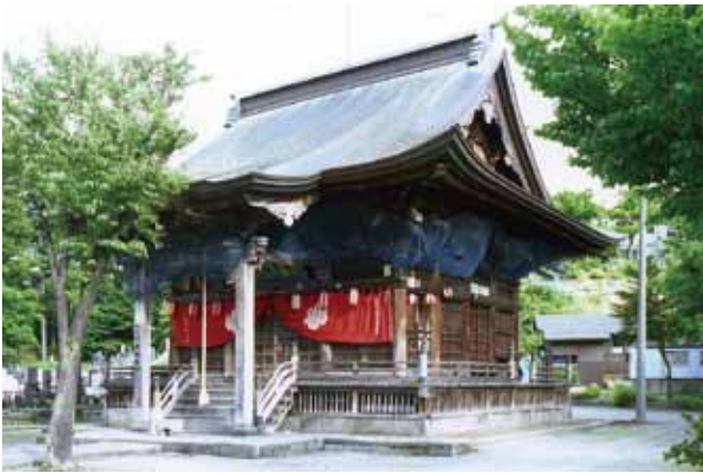
慈眼寺 観音堂 北西より
