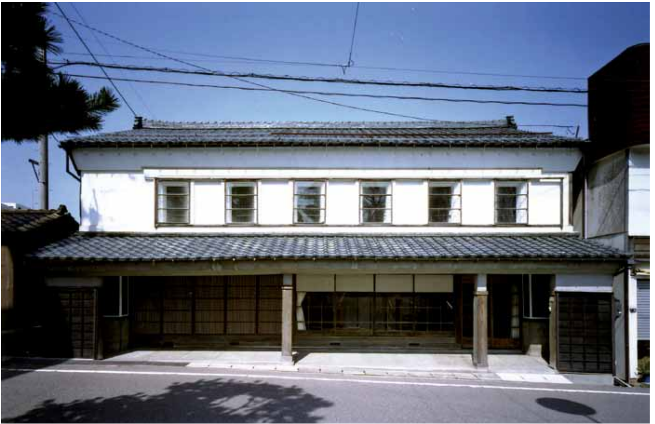
河合家住宅主屋 外観 南東より
