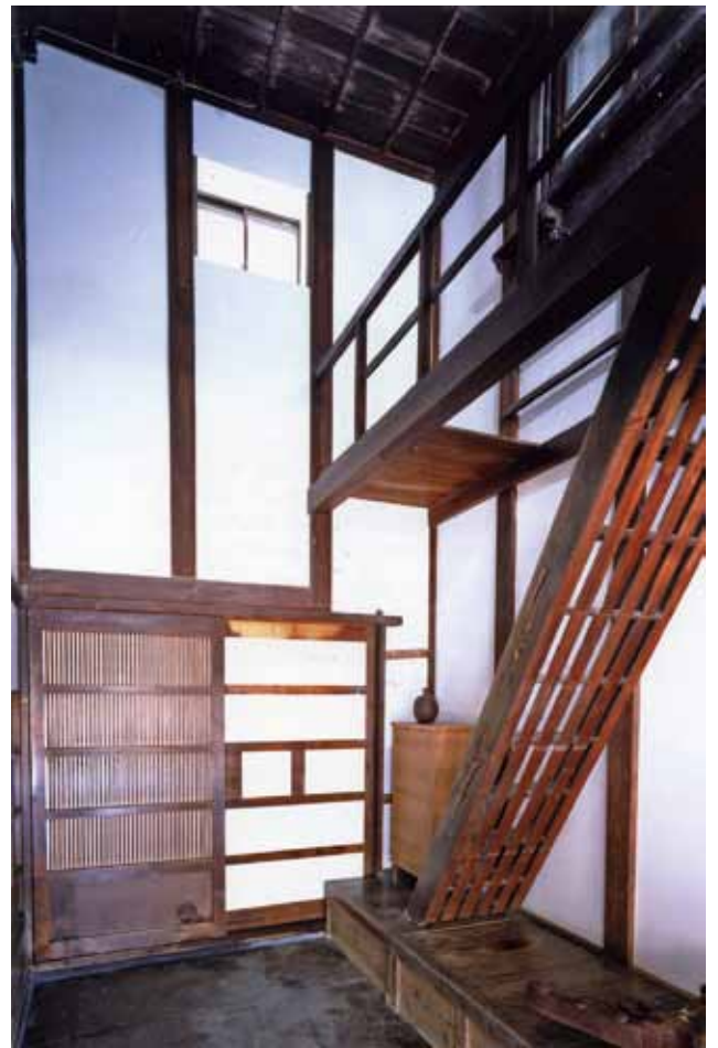
河合家住宅主屋 土間 南西より いずれも田村収撮影
