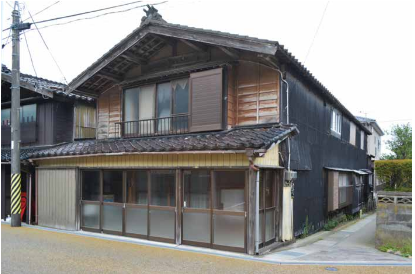
写真 1 旧津又邸外観 南東より
