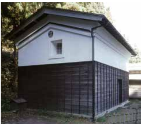
写真 2-4 習静菴 土蔵 南より
