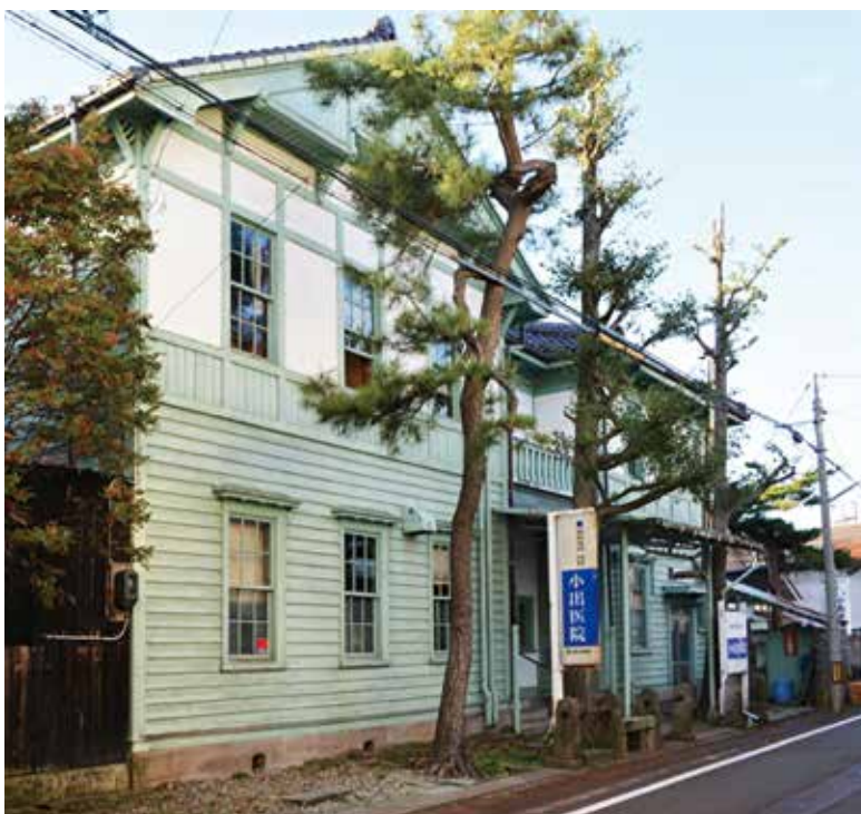
小出医院診療棟 南西より
