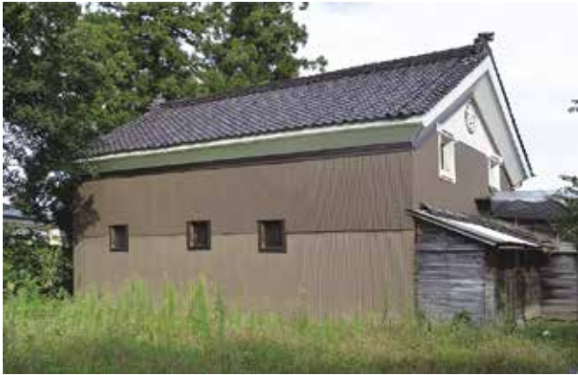
写真4 貯蔵庫 外観 南東より
