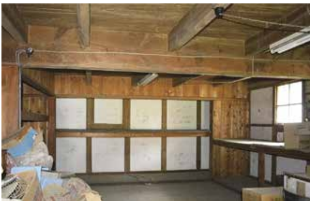
写真10 一号倉 内部1階 西より
