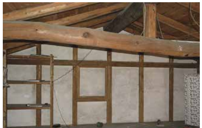
写真11 一号倉 内部2階 西より
