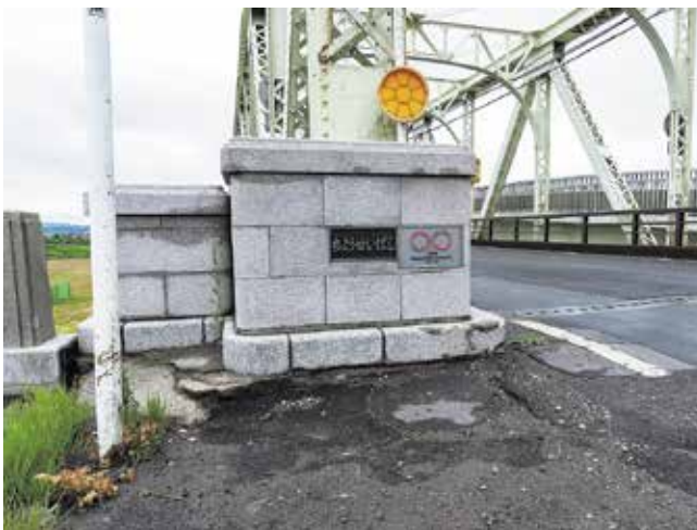
記念プレートの設置（長生橋の東詰め、アルミニウム合金鋳物、330mm × 200mm）
