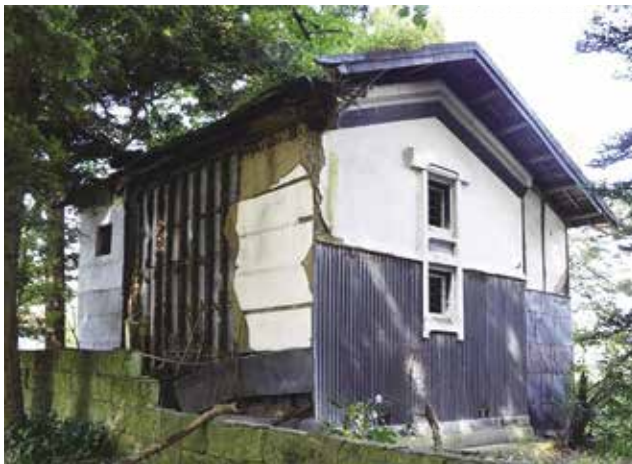
写真2 シチレン蔵 外観南東より
