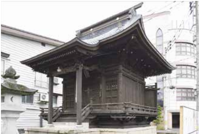
写真2 本殿 外観 南東より
