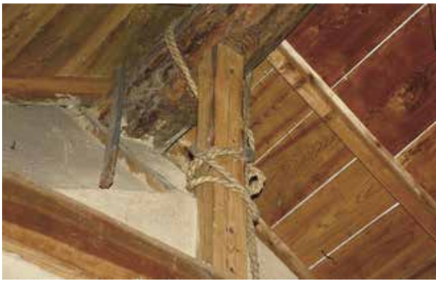
写真6 貯蔵庫 内部2階 妻面東壁 北西より
