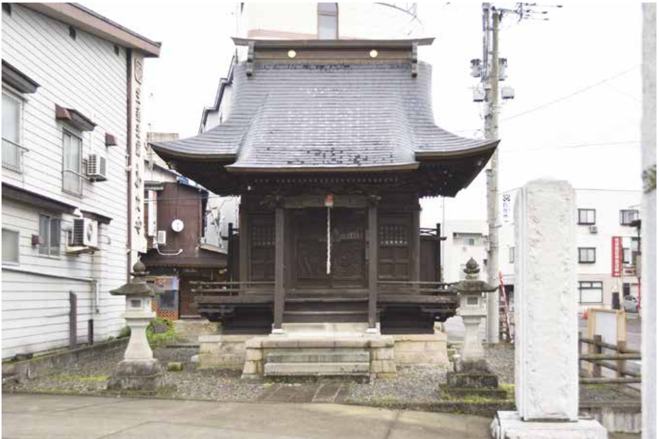
写真1 本殿 外観 南より
