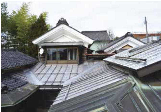
写真 4-1 マエノクラ 南より
