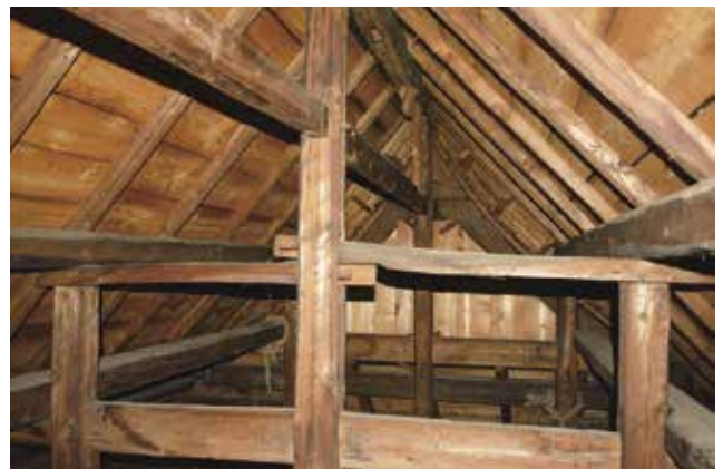
写真5 本殿 小屋裏 東より
