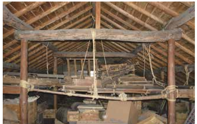
写真7 貯蔵庫 内部2階 東より
