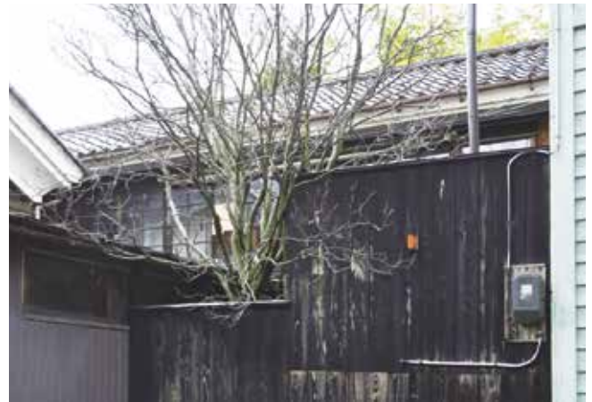
写真 4-2 マエノクラ、通路、ナカグラ 北東より
