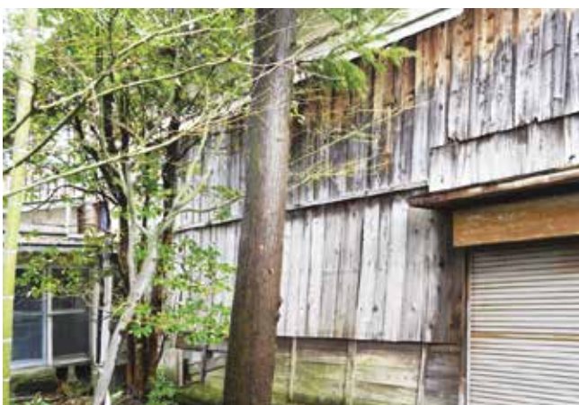
写真 4-3 ナカグラ、通路 南西より
