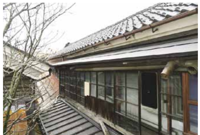
写真 4-4 マエノクラ、通路 北より
